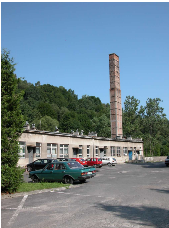
Budynek pralni i kotłowni
