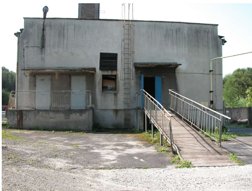
Budynek pralni i kotłowni
